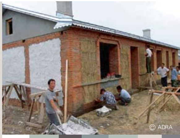
建设中的草砖房 Straw bale house under construction
